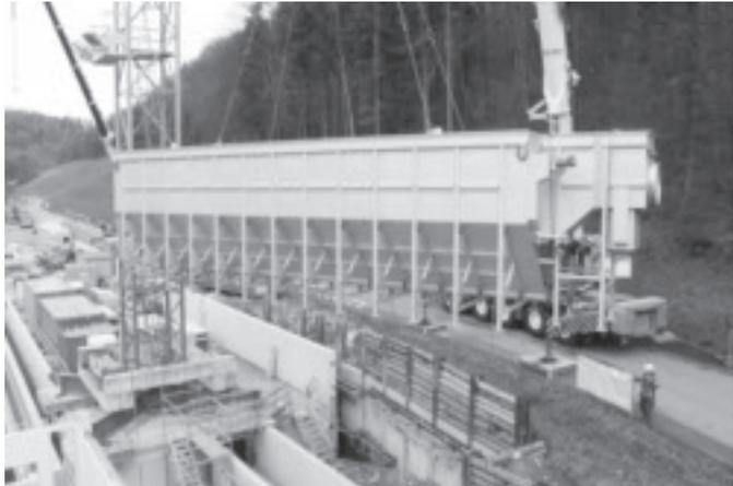
res Material wie Kies und Steine abgetrennt werden. Danach gelangt das Abwasser in einen Rechen bei dem weitere Feststoffe ausgesiebt werden. Neu ist dies ein sogenannter Feinrechen. Leider fallen immer wieder unnötige und nicht in die Kanalisation gehörende Materialien an, wie Wattestäbchen, Katzensand, Tampons und vieles mehr. Bei der bisherigen Anlage waren die Rechenstäbe viel weiter auseinander und es gelangten immer wieder unerwünschte Materialien weiter auf die Anlage.
