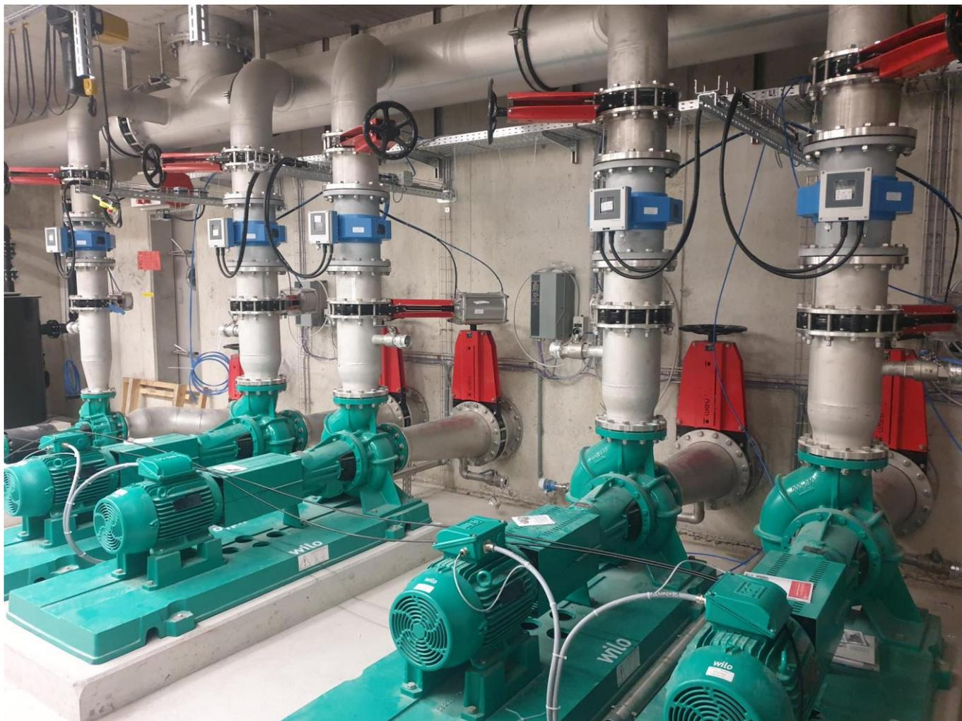
Abbildung 2: Das neue Zulaufhebwerk zur Förderung des Abwassers ins Ozonbecken.
