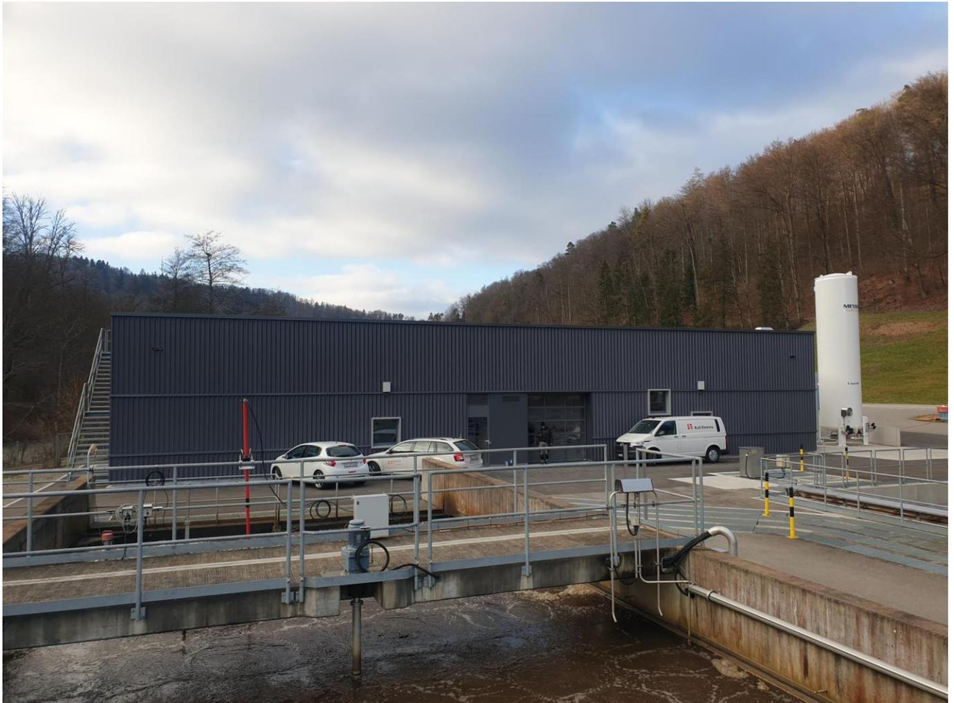
Abbildung 1: Das neue EMV Gebäude steht, mit flüssig Sauerstofftank (rechts im Bild) zur Ozonerzeugung.
