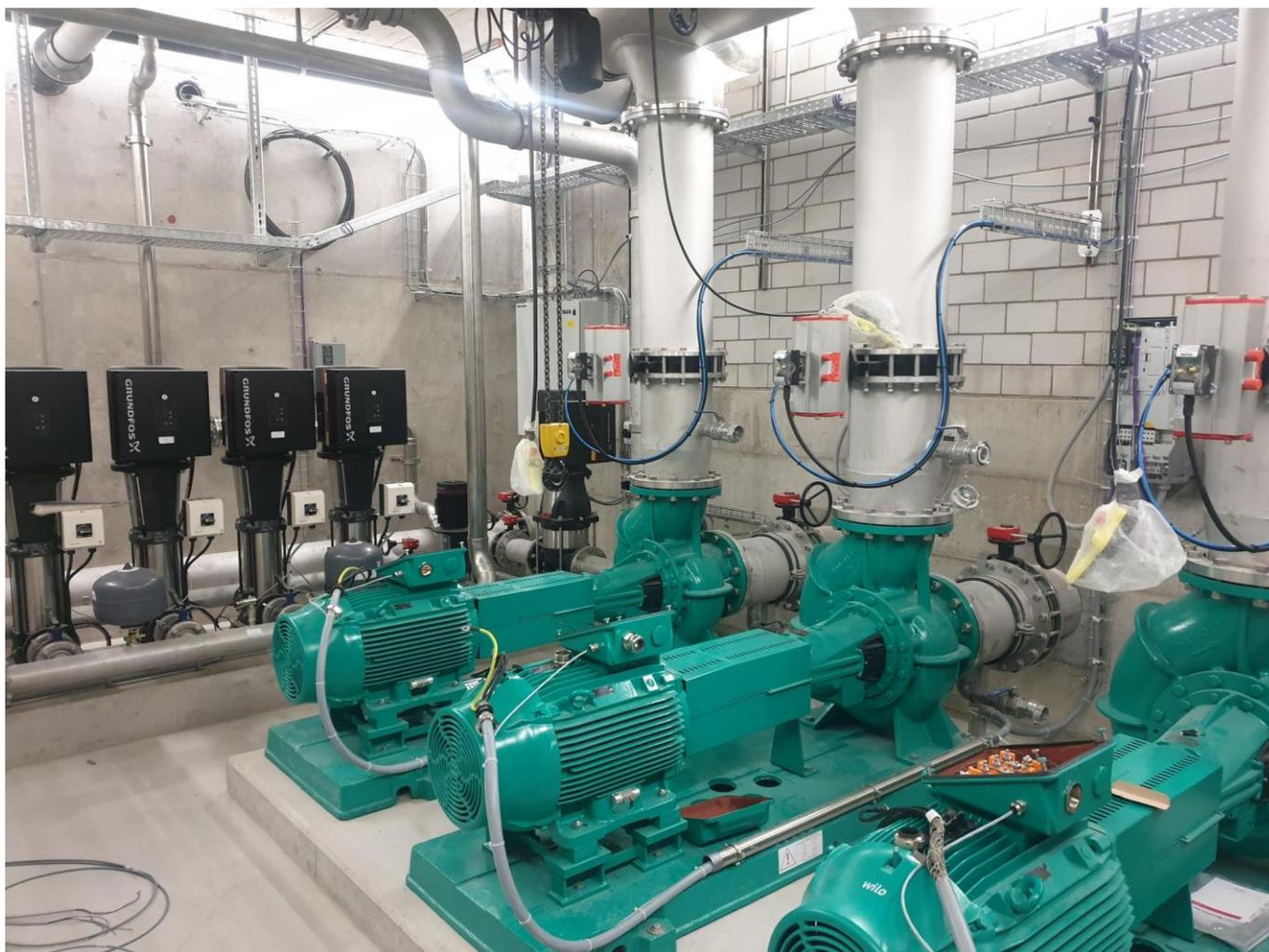
Abbildung 3: Die drei massiven Rückspülpumpen zum Aufwirbeln des Filterbetts.
